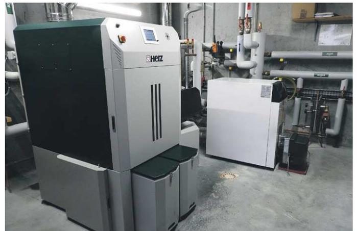
Une chaudière bois, au 1er plan, et au cas où... problème de panne, une chaudière fioul pour prendre le relais (au 2d plan)
