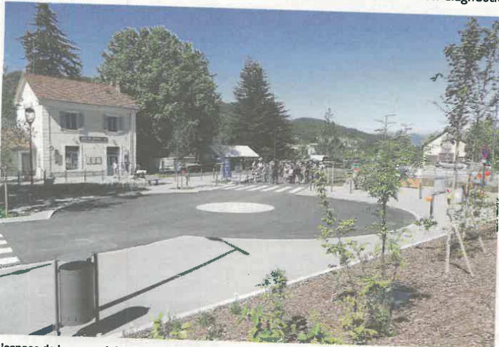
L'espace de la gare a été entièrement reconfiguré
