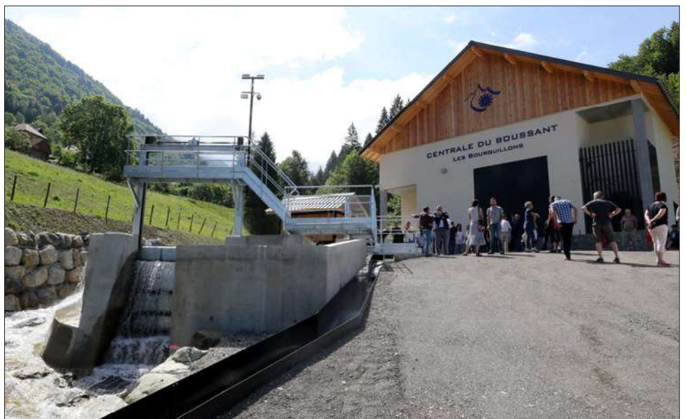
La centrale du Bousant a nécessité un an de travaux et 19 entreprises ont participé à sa construction. Photos Le DI/Marc GREINER
